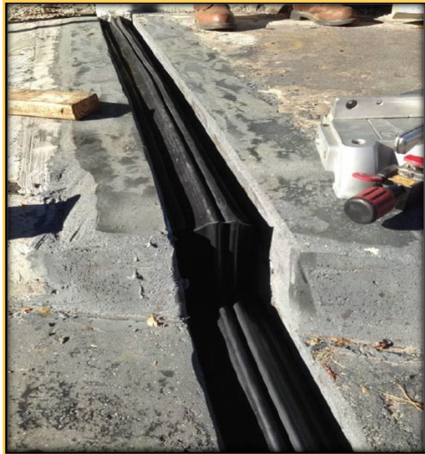
Sello SF500 empalmado para la transición de la carretera, la acera y la acera
