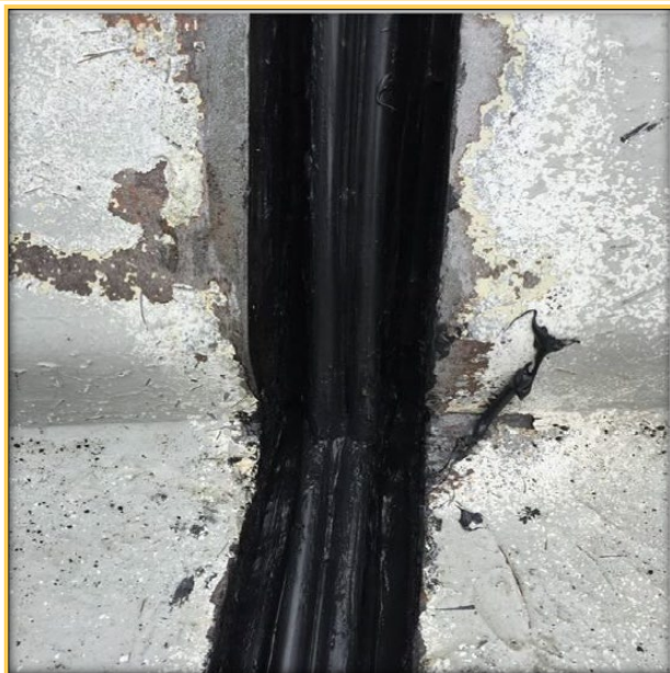
Sello SF400 empalmado para levantar una pared de barrera
